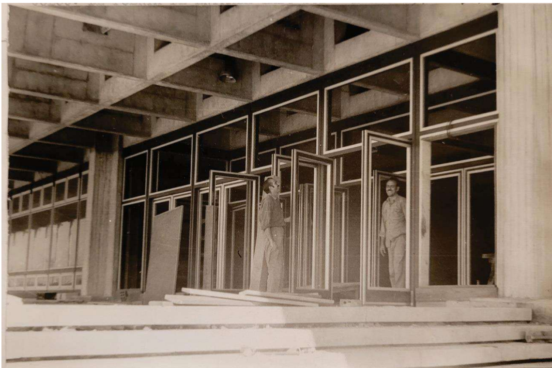
Figura 2: Colocación de Puertas de Entrada Lado Sud – Pabellón 2- 1970
