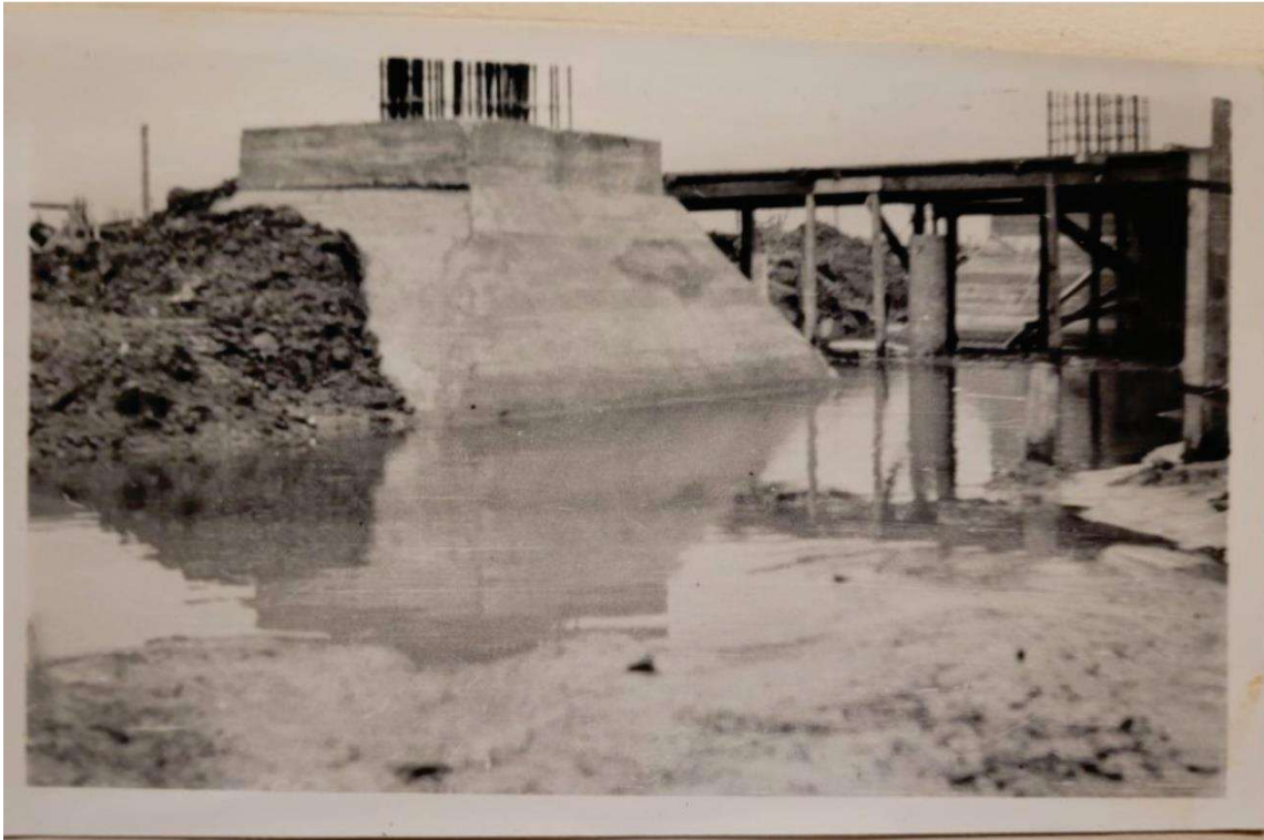
Figura 1: Pilotaje y bases. Pabellón 2. 1963
