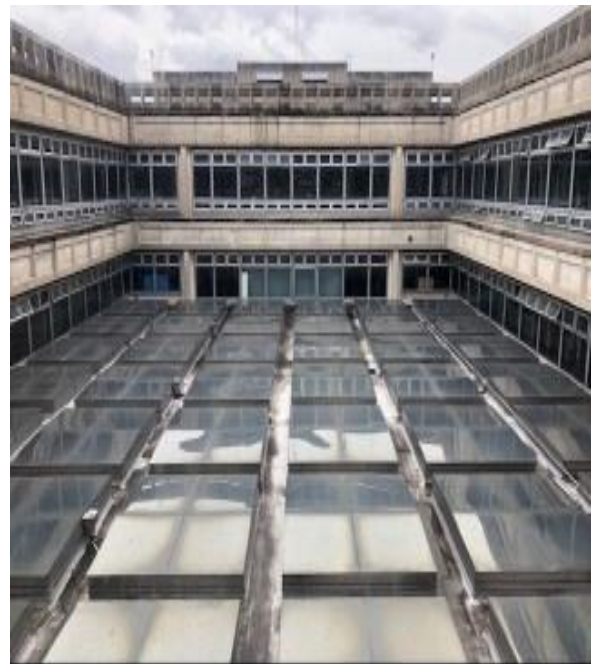
Cubierta en el 3 er nivel .
