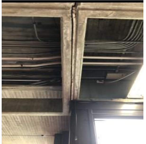
Instalaciones y juntas de dilatación.
