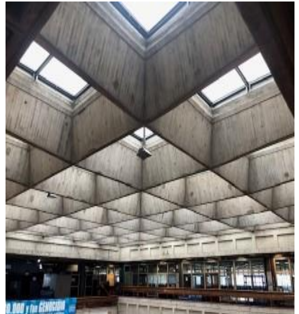
Cubierta como pañuelo tensado
